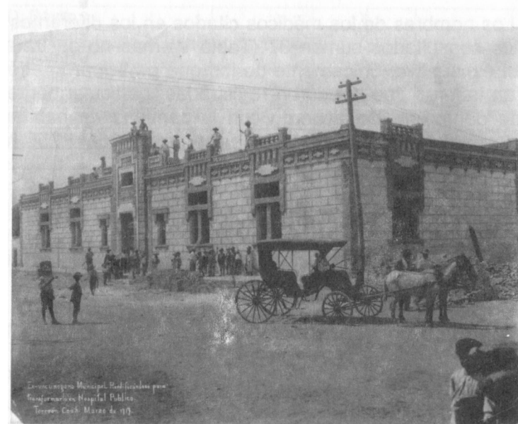
Foto 17. Vacunógeno en construcción. Torreón, Coah.
