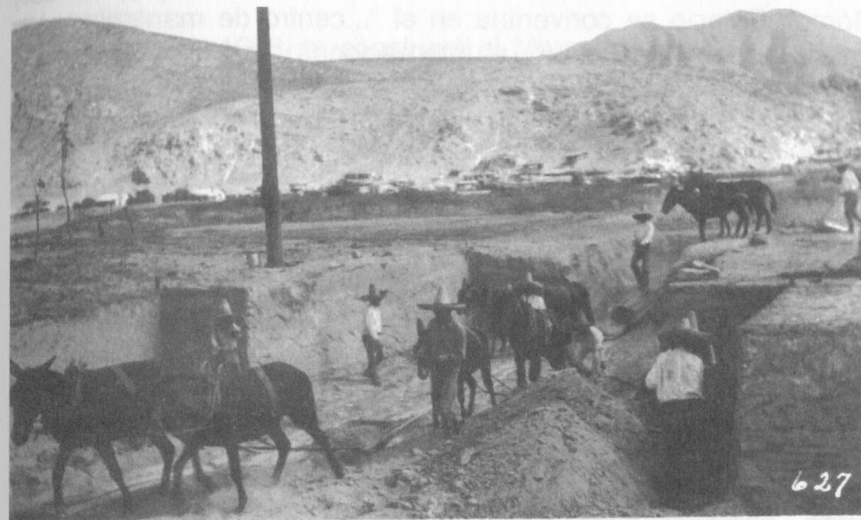
Foto 4. Campo lagunero. Construyendo campo de irrigación.
