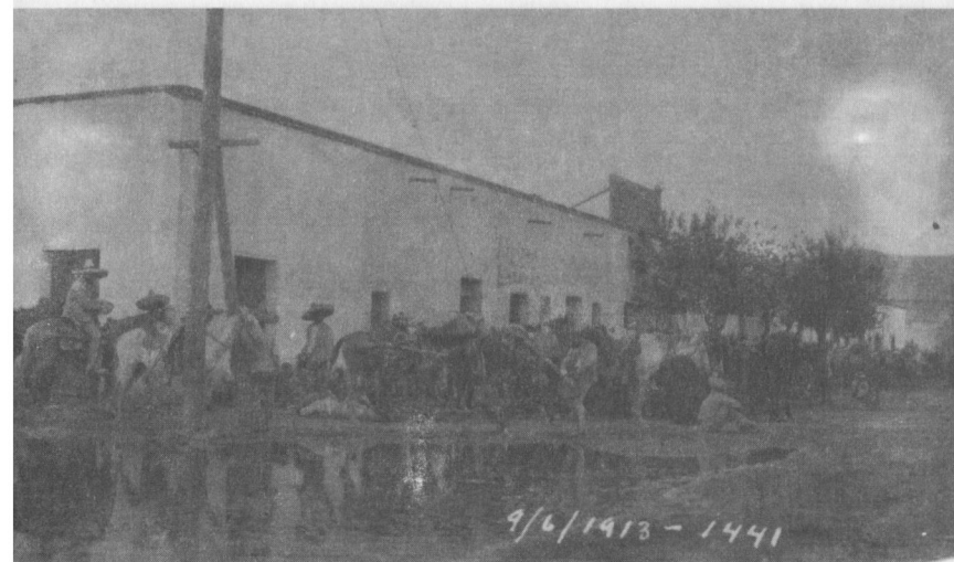
Foto 20. Calle encharcada en Torreón, Coah.
